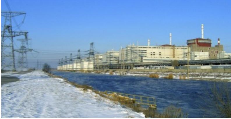
Figura 10: Centrale di Zaporizhzhia con il canale che fornisce l'acqua per i sistemi di raffreddamento.
